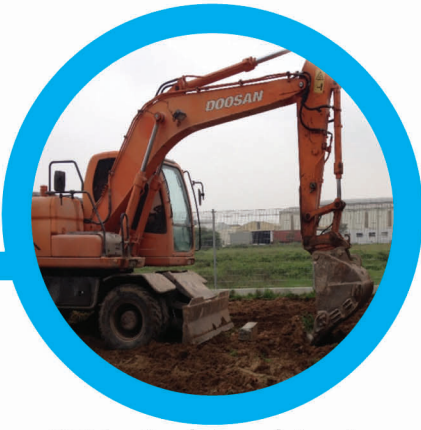
2014, xây dựng nhà máy
